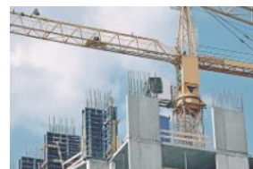
建設 ロジスティクス
